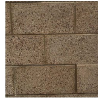
CMU PATIO WALLS
