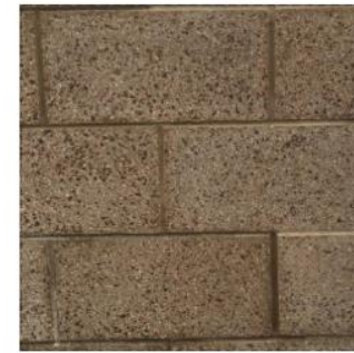
CMU PATIO WALLS
